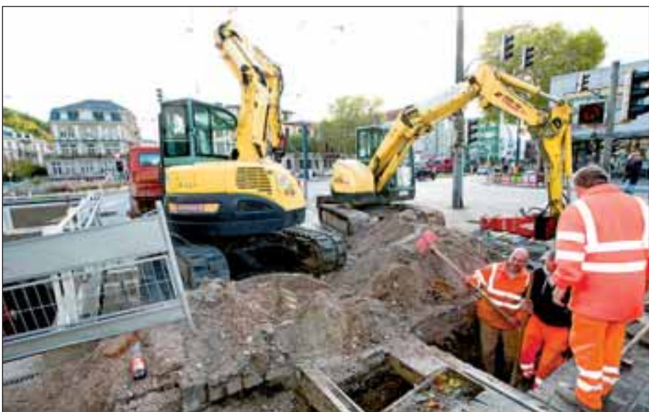
Die Gleisarbeiten am Adenauerplatz sind in vollem Gange. Seit Sonntagabend sind die Schienenstränge für alle Straßenbahnen gesperrt. Das befürchtete Verkehrschaos blieb nach Angaben der Rhein-Neckar-Verkehr GmbH (RNV) aber aus. „Wir hatten ein sehr hohes Kundenaufkommen am Hauptbahnhof“, berichtete Unternehmenssprecherin Susann Becker. Dort müssen derzeit Fahrgäste der Linien 5 und 26, die in die Innenstadt wollen, in Busse umsteigen. Außer fünf- bis zehnteiligen Verspätungen, so Becker, habe es aber keine besonderen Vorkommnisse gegeben. Die Beschwerden blieben im üblichen Rahmen. hob/ Foto: Kresin
